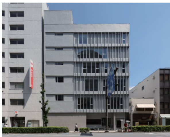
浅草複合ビル耐震改修
