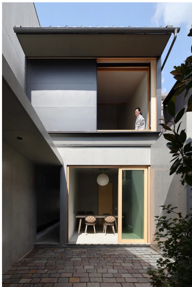
カフェ棟とオフィス棟の間にある中庭
